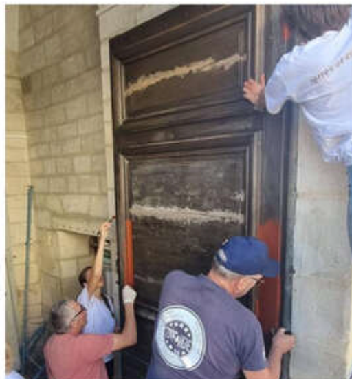
La mise en peinture en cours de la grande porte de l'église. Photo V. A.
